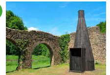
Halles à charbon Bento/Futur Primitif
